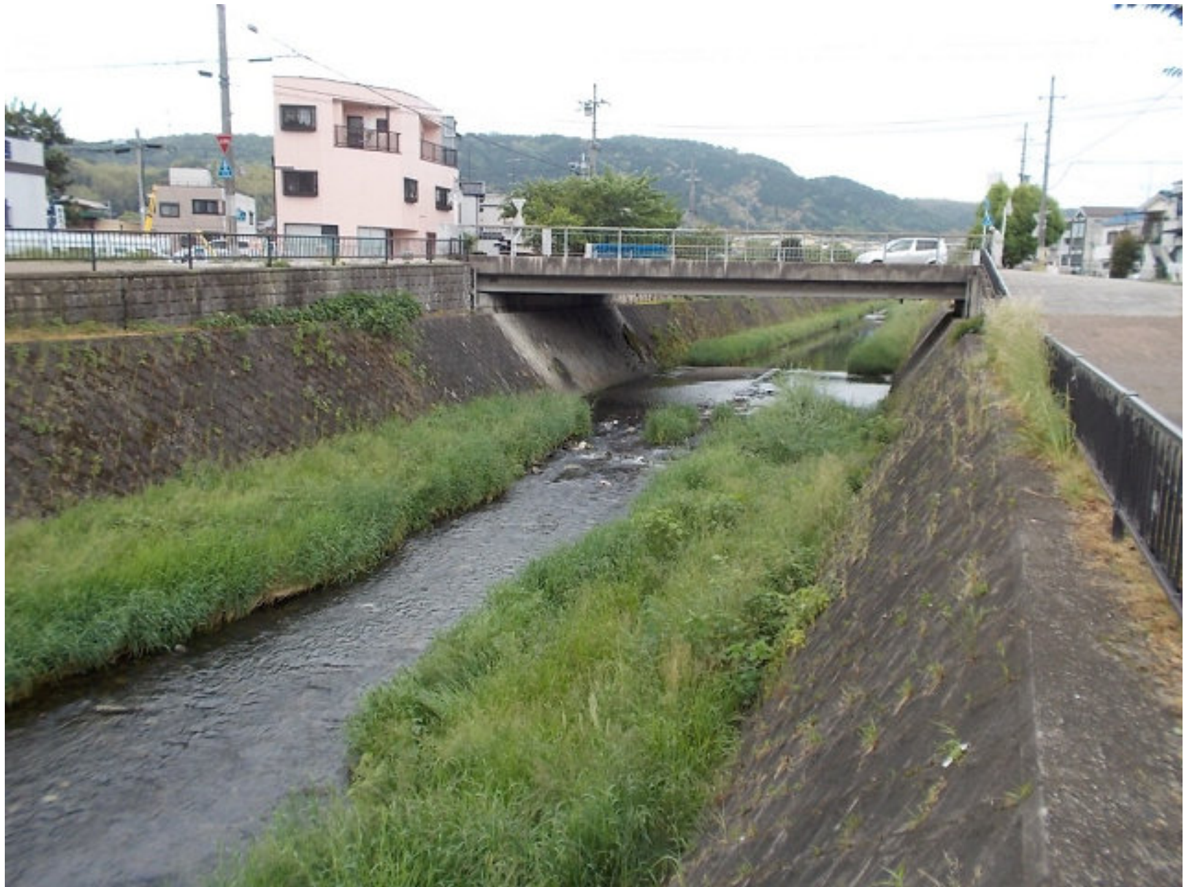
旧安祥寺川 金ヶ崎橋
