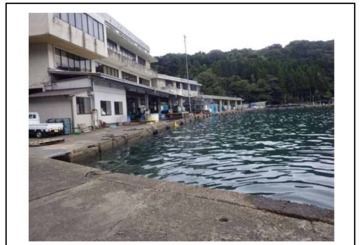
大浦第1岸壁 全景
