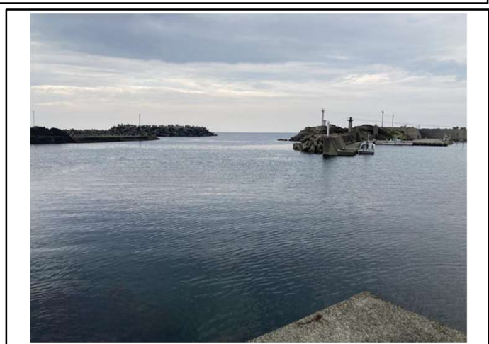
間人漁港 防波堤
