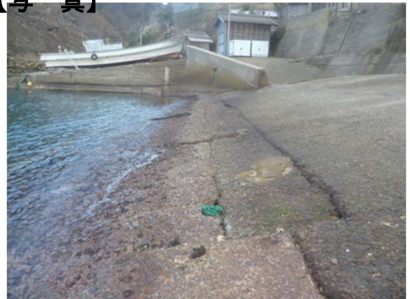
【浜詰漁港】塩江船揚場
