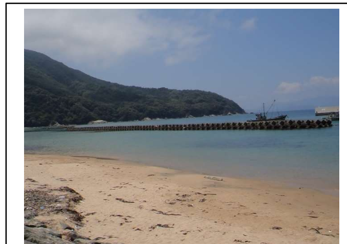
防砂突堤整備
