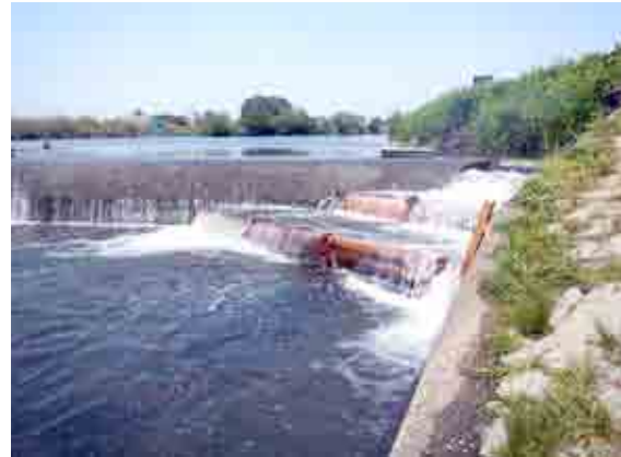
堰に設置された魚道（京都市鴨川）
