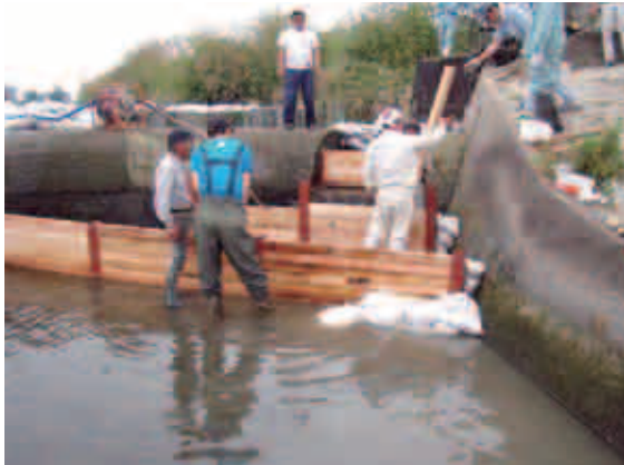
魚道を設置する様子
