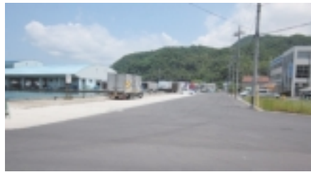
漁港整備を進めています（舞鶴漁港）
