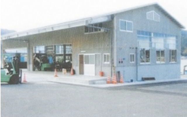
衛生管理の充実(四方を壁等で囲う等)を図った水産物荷さばき施設(宮津市)
