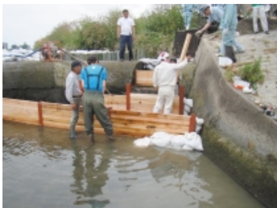
魚道を設置する様子
