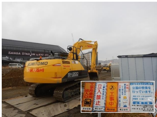
D 地点（工事実施状況）
