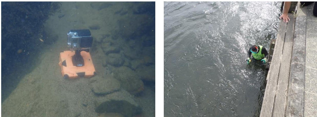
図 1-35 水中 CCD カメラ設置状況（左：設置の様子、右：設置風景）
