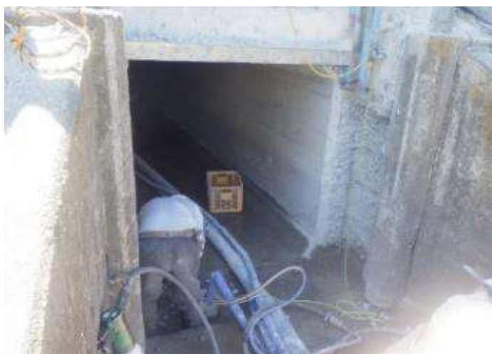
【写 3-1-4 ハツリ状況】
