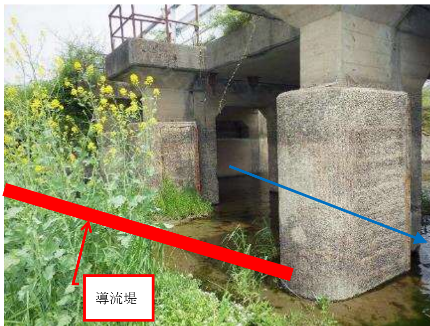
【写 3-1-1 導流堤設置橋脚部 撮影日 H31. 4. 23】
