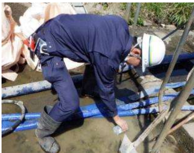
【写 3-1-6 コア抜き時採水状況】
