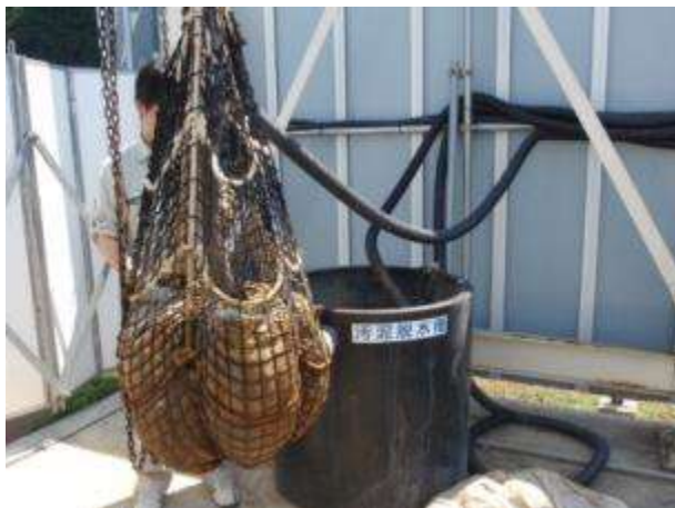
【写 3-1-3 排水濾過参考写真】
