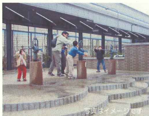
公園の耐震性貯水槽
