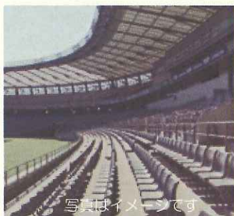
写真はイメージです 光を通す太陽光発電屋根
