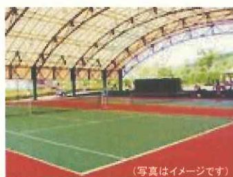
テニスコート屋根設置 (写真はイメージです)
