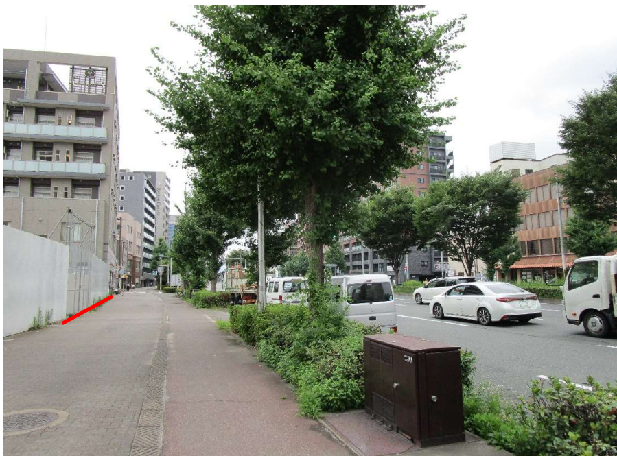
南東側より撮影
