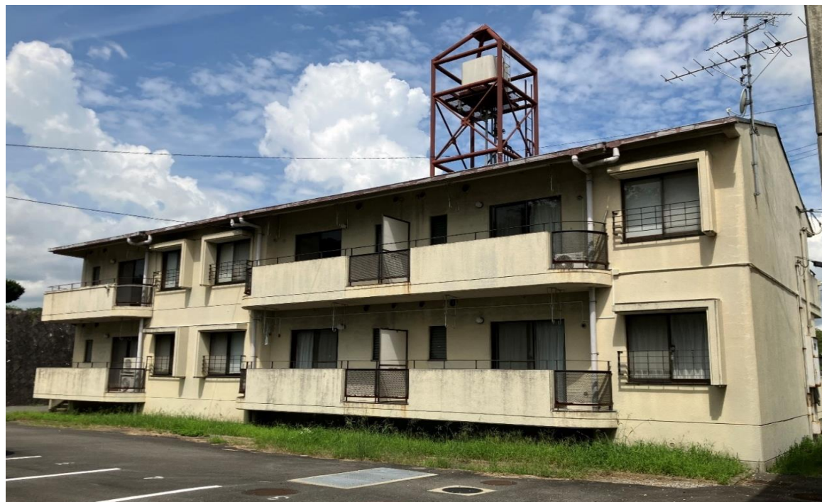
建物②(東側より撮影)
