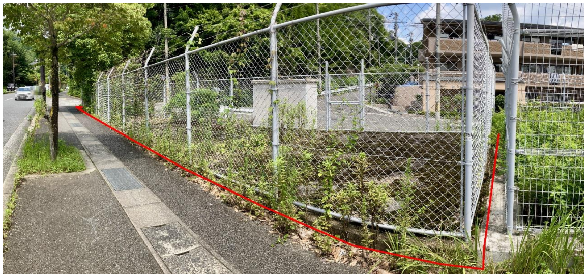
南東側より撮影
