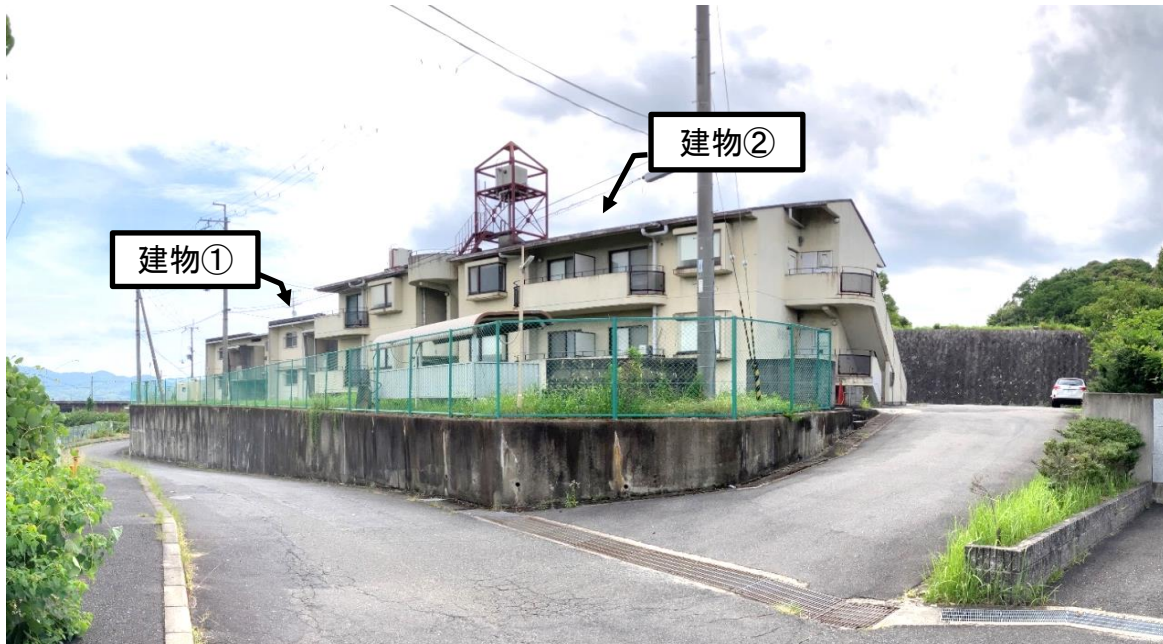
建物①②(遠景・西側より撮影)
