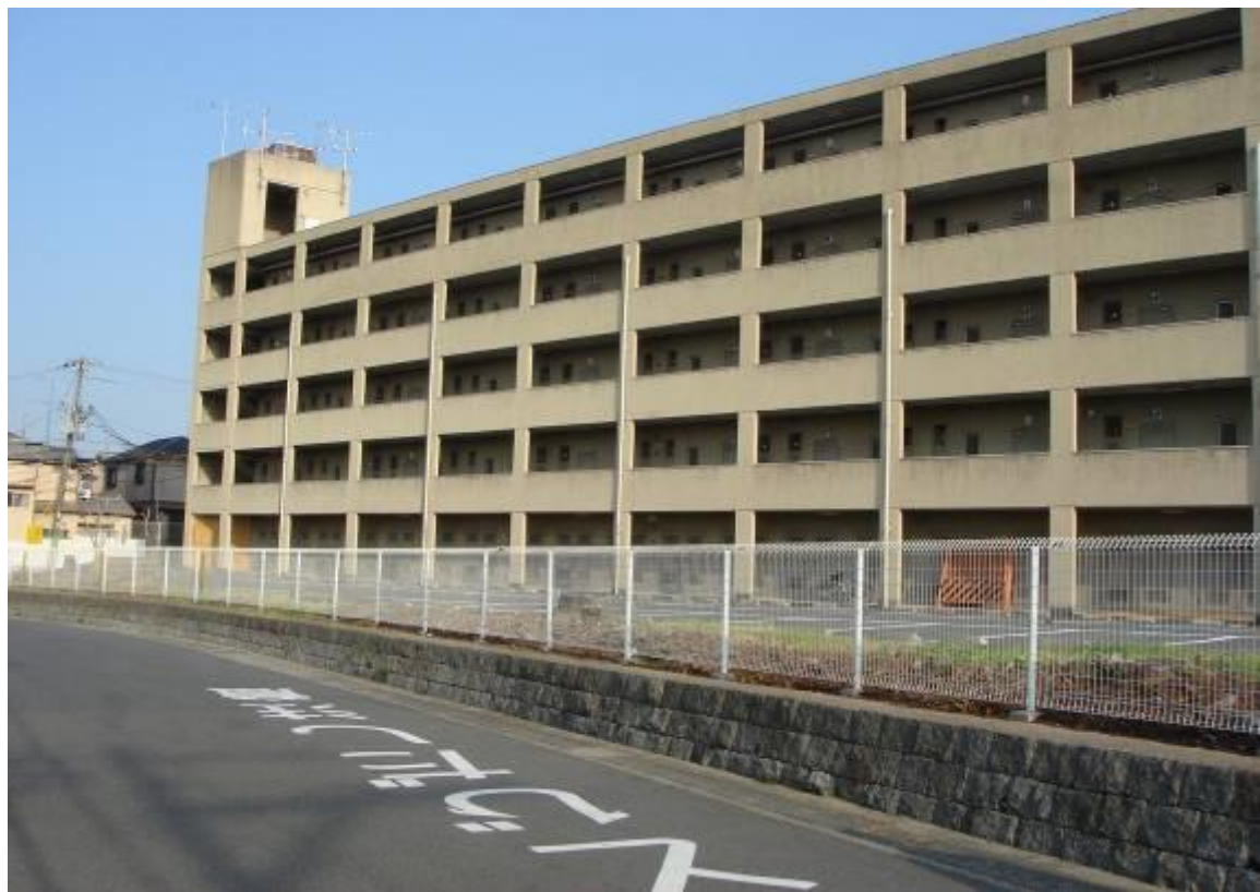
▲ 北西方向から
