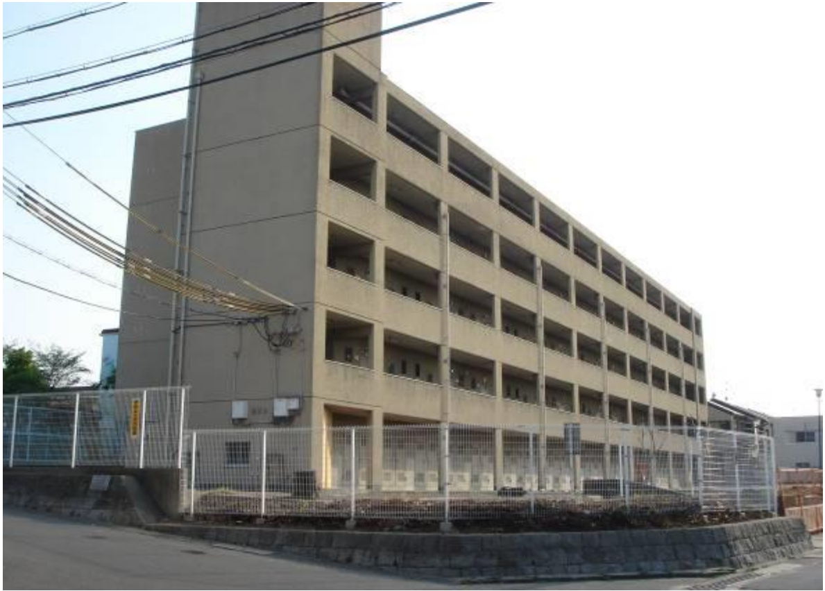
▲ 北東方向から
