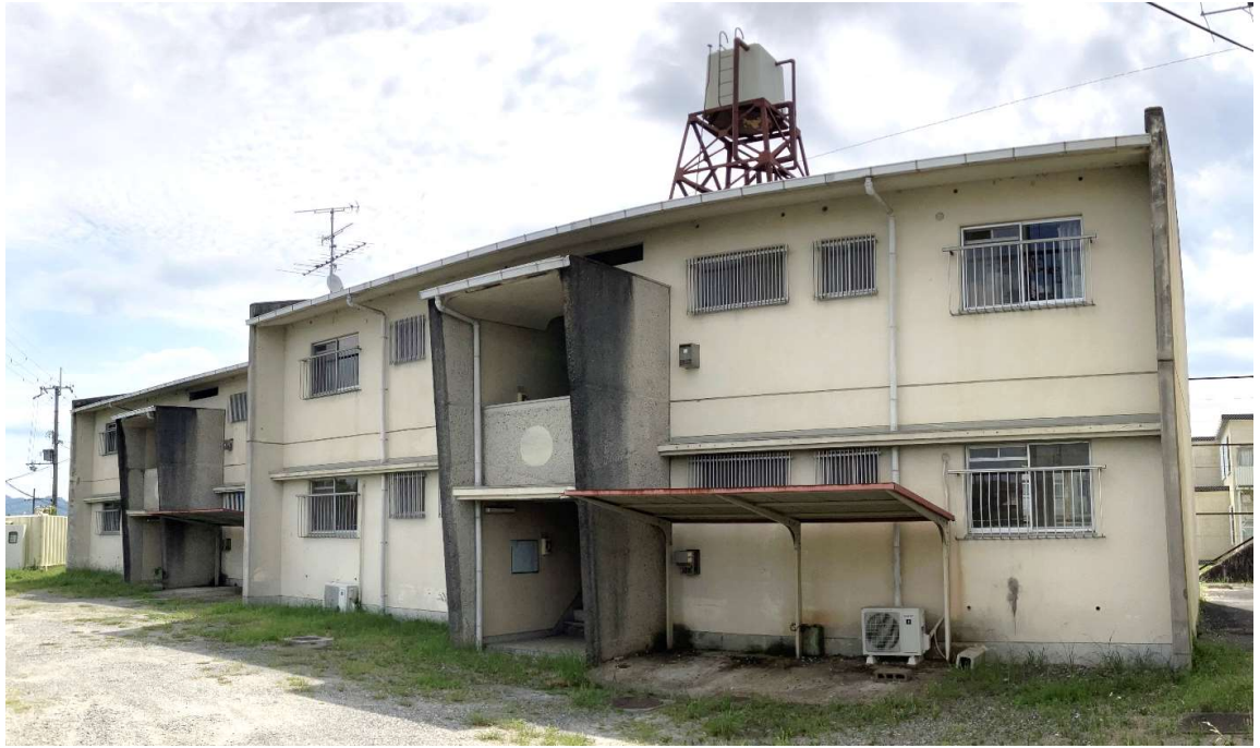
建物①(西側より撮影)
