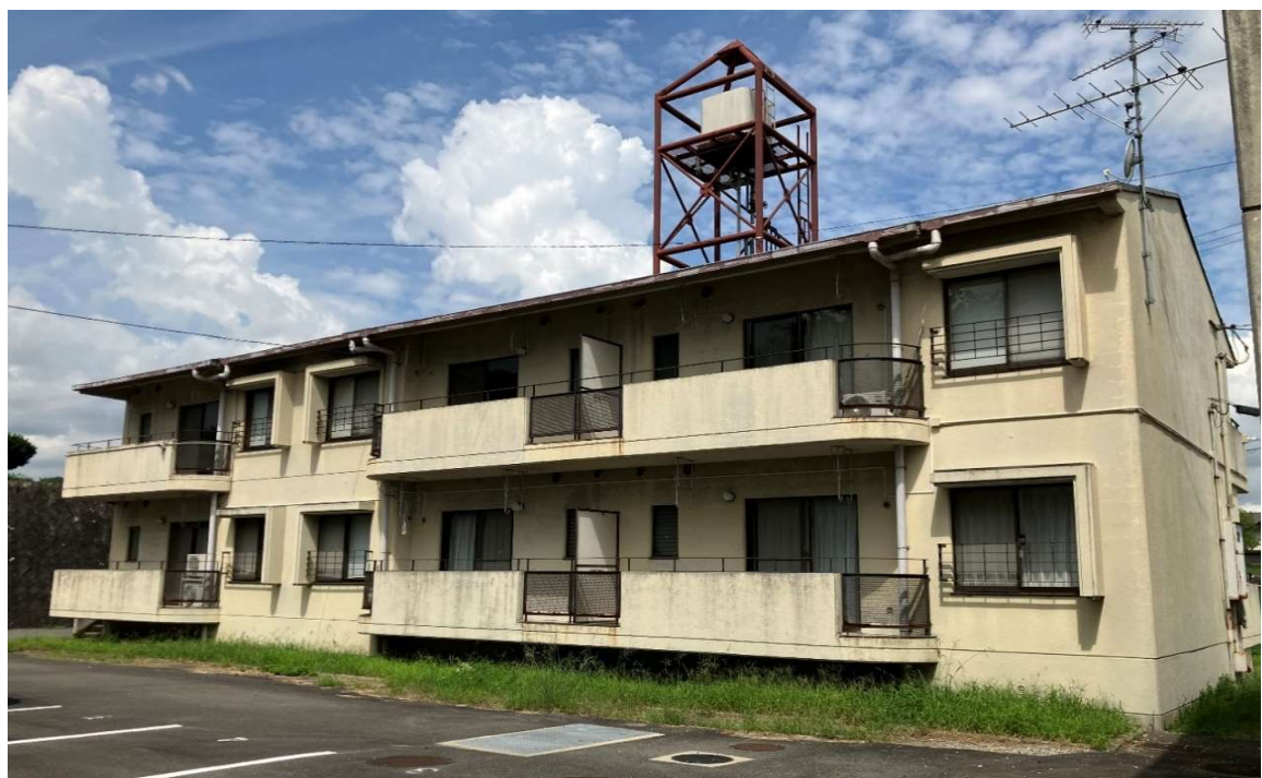
建物②(東側より撮影)
