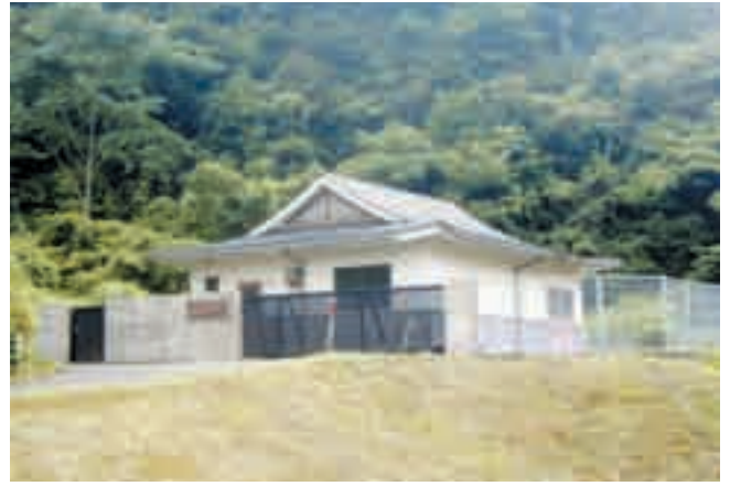
漁業集落排水処理施設（伊根町）
