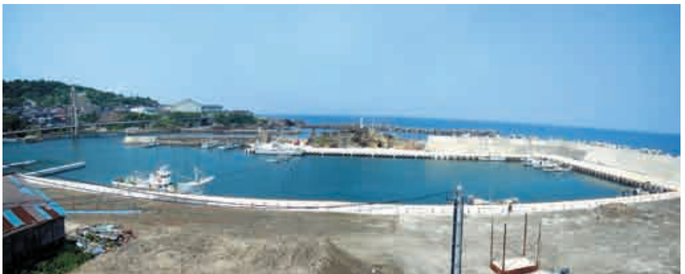
漁港整備を進めています(京丹後市丹後町間人地区)
