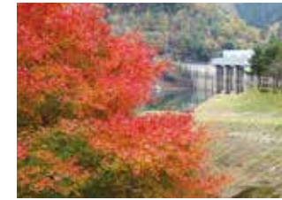
大野ダム(南丹市)
