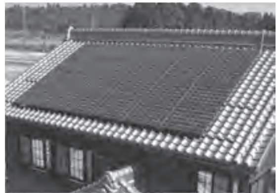
再生エ設備を設置した住宅
