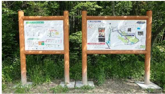
・京田辺市 散策路の案内板を設置
