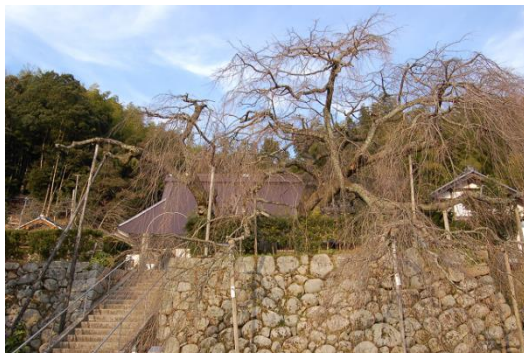
施工前 支柱改修
