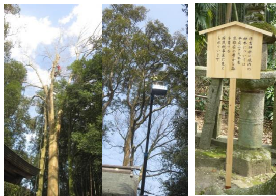
高所での作業
