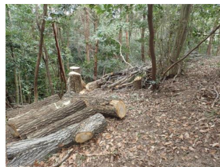
ナラ枯れ枯死木伐採
