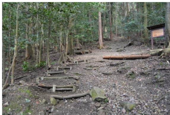
管理歩道補修
