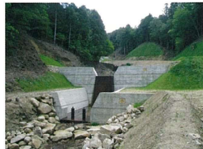
流木捕捉式治山ダム
