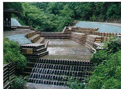
木製治山ダム
