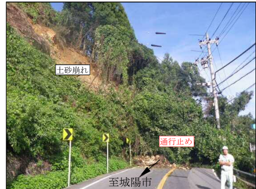
写真-3 被災の様子 (平成25年9月)
