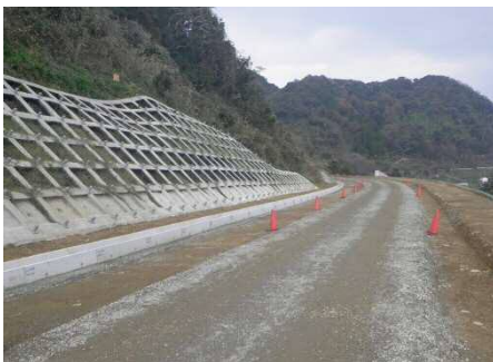
写真-3 施工直後の状況
