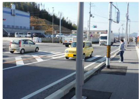
【写真8】開通後（バイパス部）
