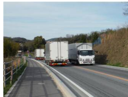
【写真4】開通後(バイパス部)
