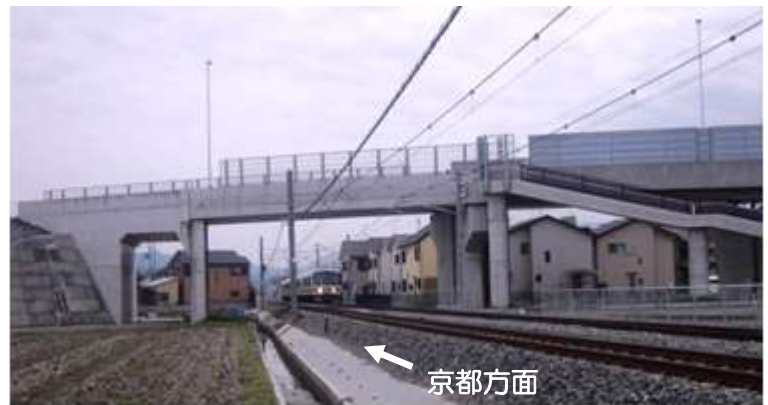
写真⑥ JR高架橋の整備状況
