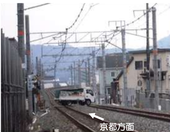
写真⑤ 宇津根踏切の状況
