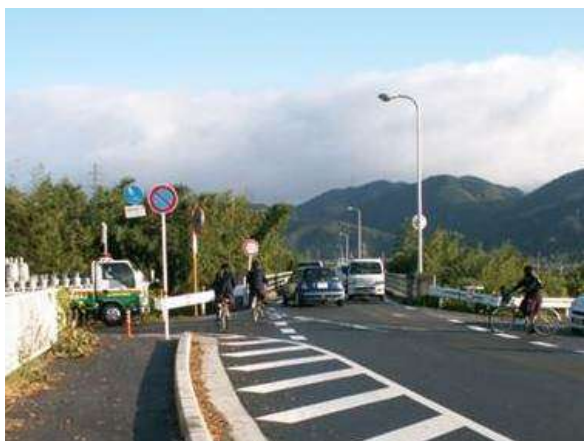
写真⑪ 宇津根橋の状況
