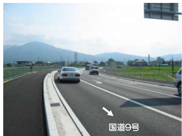
写真⑩ 郷ノ口余部線 (国道9号交差点付近の状況)
