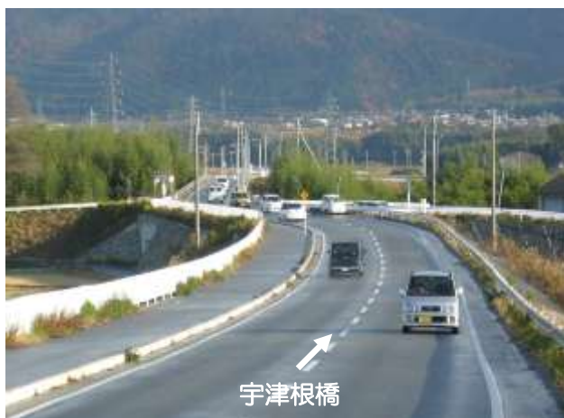
写真⑨ 郷ノ口余部線 (宇津根橋以南の状況)
