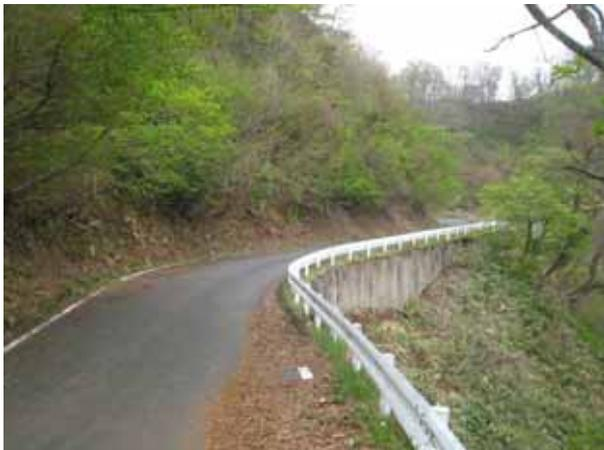
写真 コンクリート擁壁工
