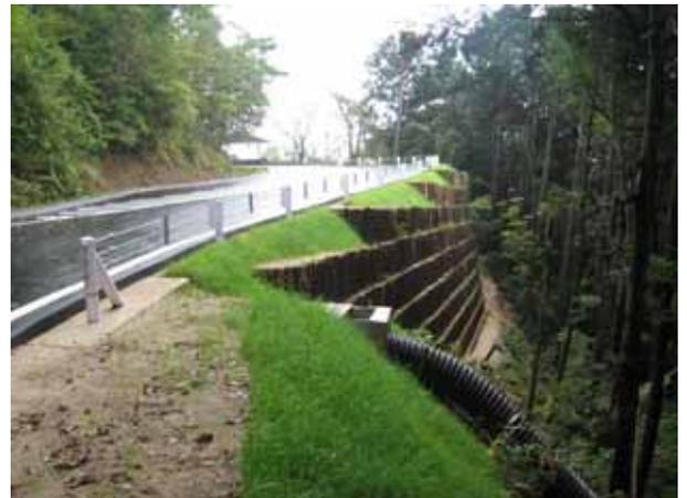
写真 補強土壁工
