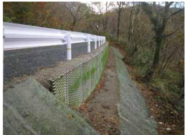
写真 鋼製L型擁壁工
