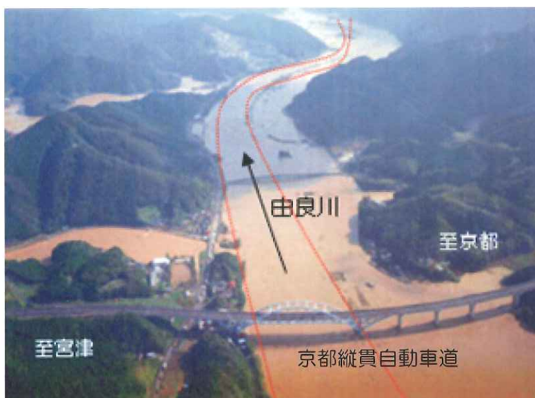
参考 京都縦貫自動車道（綾部宮津道路）と由良川の氾濫状況（H16.10）
