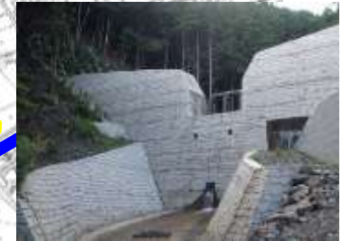
写真-⑫ 施工済えん堤
