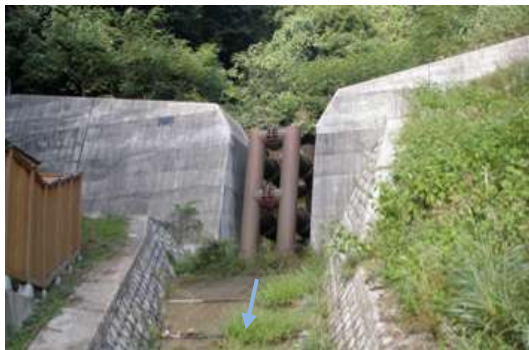
写真-15 府下での透過型えん堤の施工事例
