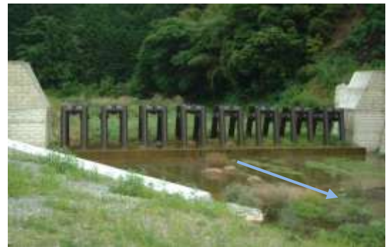
写真-15 府下での透過型えん堤の施工事例
