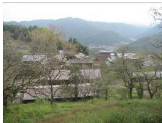
写真-⑧ 保全対象 (人家全景)
