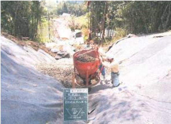
写真-⑪ 索道を使用した工事
