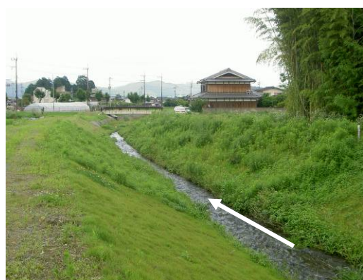
④改修後 (現況)
