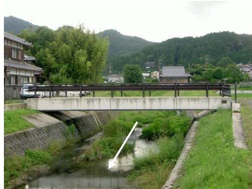
②改修後 (現況)
