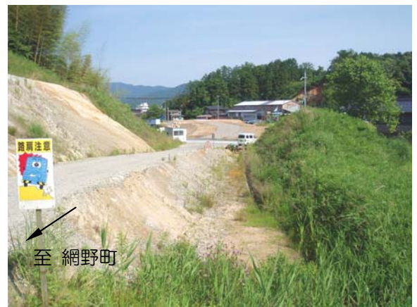
写真⑤ 木橋地区の状況
