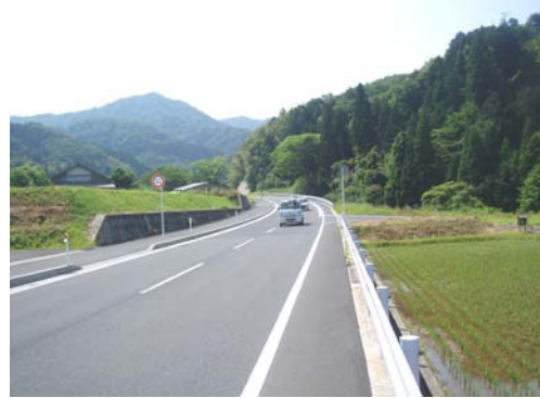
写真⑦ 供用後の等楽寺工区
