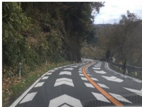
【写真-3 線形不良（S字カーブ）】
