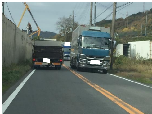
【写真-1 現況道路（現道拡幅部）】
