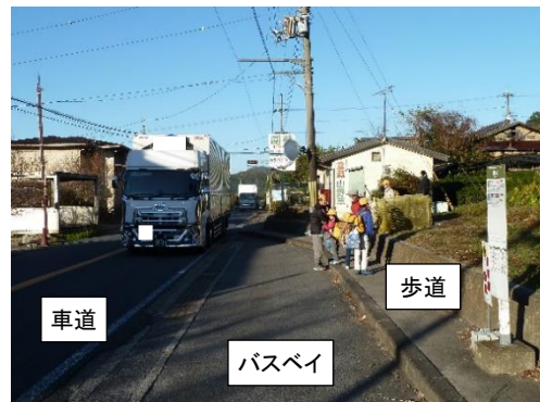
【写真-4 狭小な歩道】
