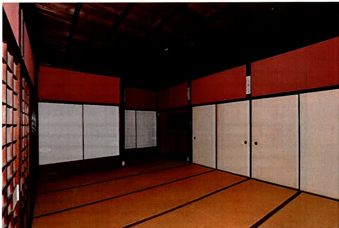
着工前の状況
