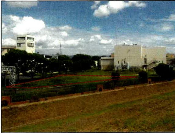
[写真2 施工予定地全景]
