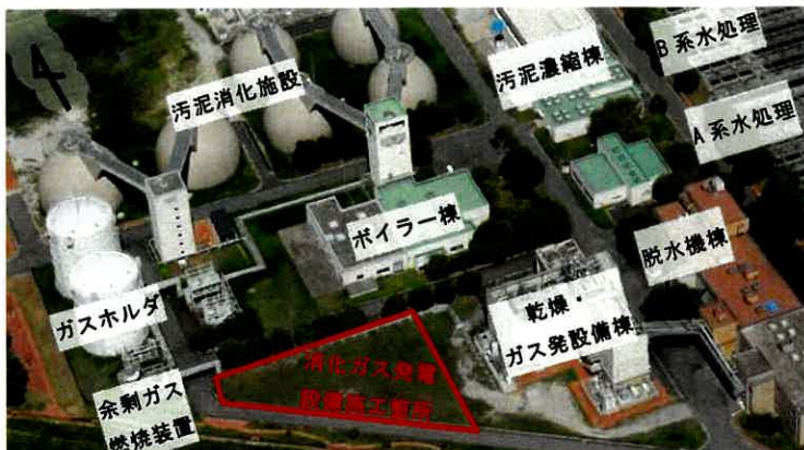
[写真1 消化ガス発電設備 施工箇所 航空写真]
