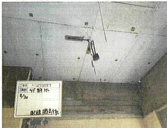
（現況）配線撤去後
