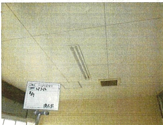
（着工前）男子トイレ上部
