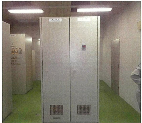
[写真2 中央監視室 監視制御設備 現況 今回更新予定]
