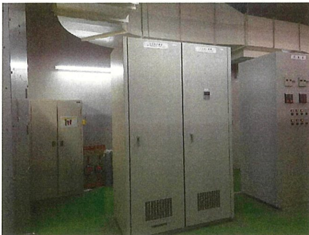
[写真2 中央監視室 監視制御設備 現況 今回更新予定]
