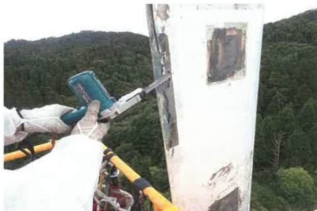
② 塗膜除去及び素地調整
