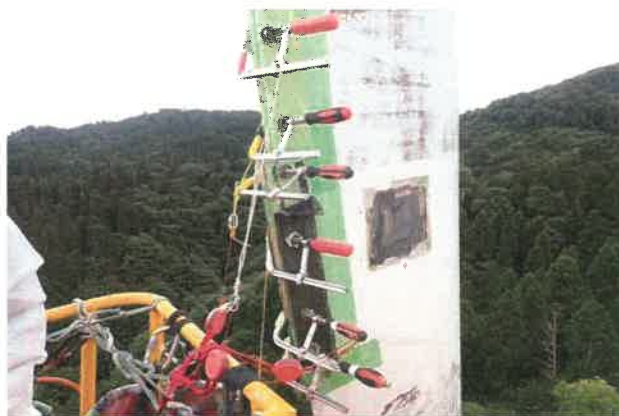
③ 割れ箇所の接着、養生
