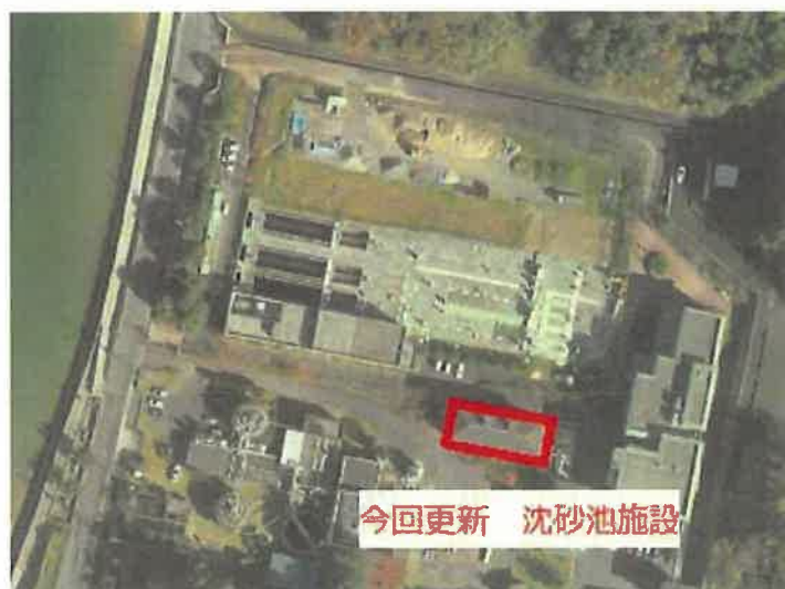
[写真1 宮津湾浄化センター全景 沈砂池施設]
