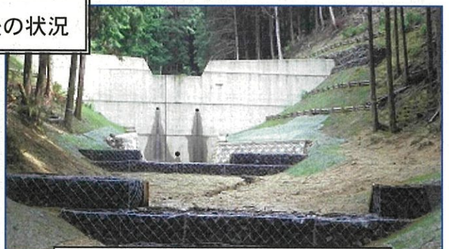
床固工(2基)・ブロック積工
