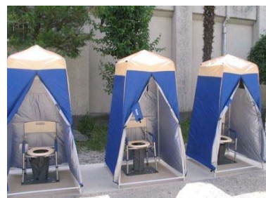
長岡京市 マンホールトイレ設置例
