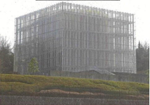
華の塔配水池
