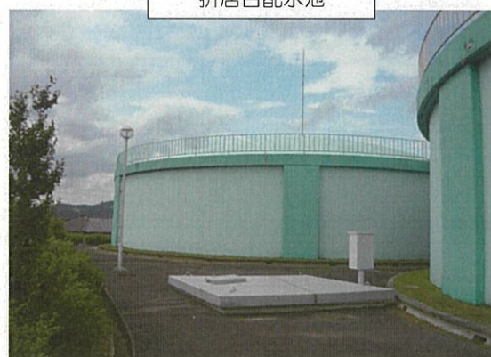
折居台配水池
