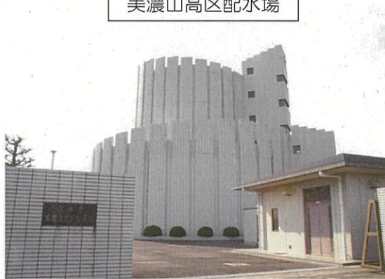
美濃山高区配水場
