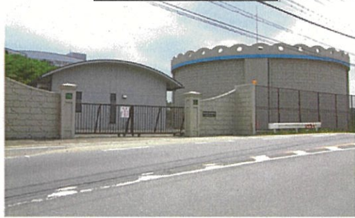
田辺高区配水池
