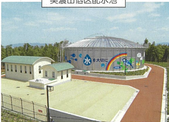
美濃山低区配水池
