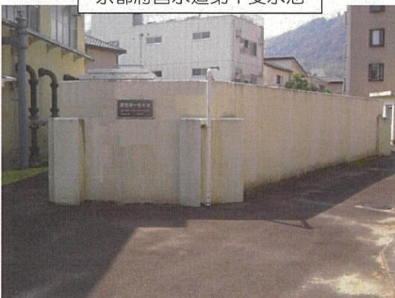
京都府営水道第1受水池
