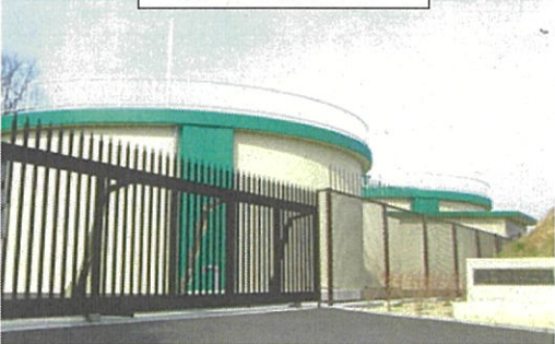
南田辺北配水池
