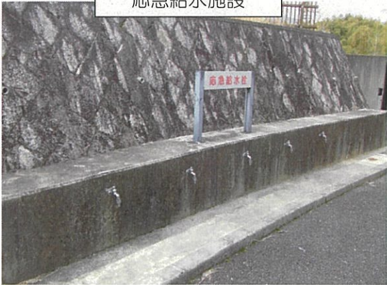
応急給水施設
