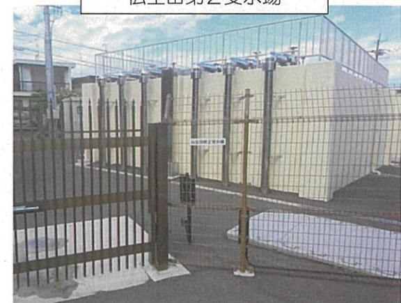
仏生田第2受水場
