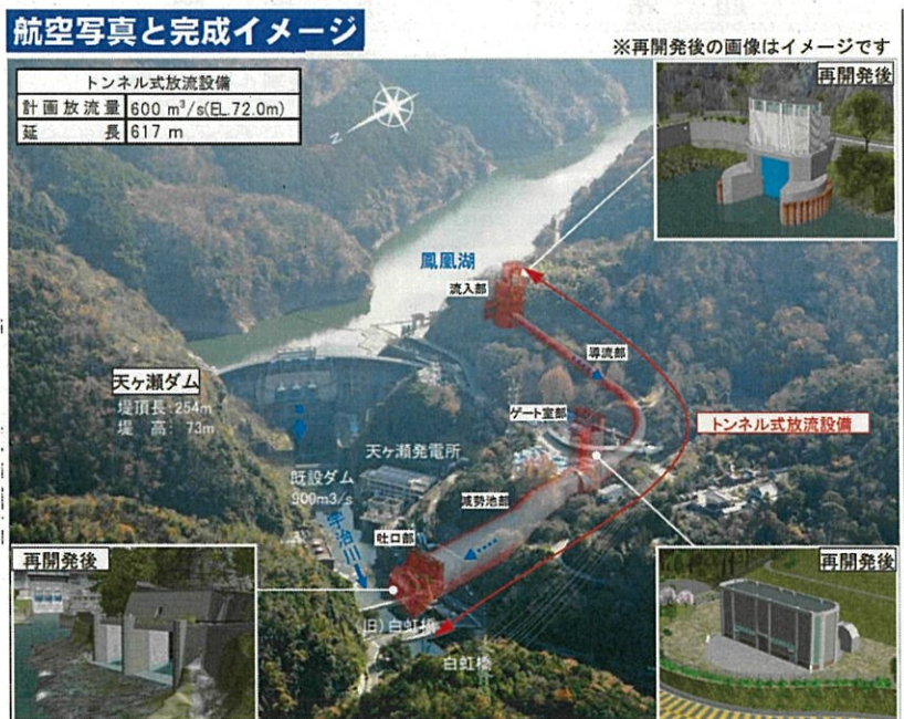
トンネル式放流設備（天ヶ瀬ダム再開発事業）
