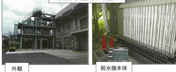
宇治浄水場排水処理施設
