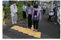
踏切部の点字ブロック立会い
