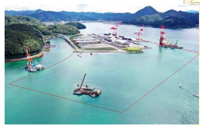
舞鶴国際ふ頭II期整備施工箇所
