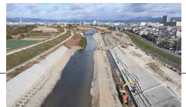
河川改修(鴨川)
