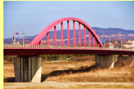
国道307号山城大橋（城陽市・京田辺市）
