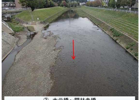
③ 大元橋～閑林寺橋
