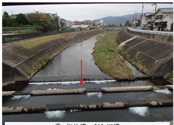
⑤ 栂辻橋～封シ川橋
