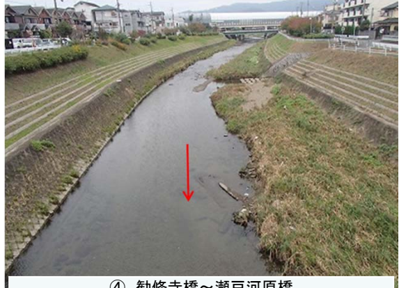
④ 勧修寺橋～瀬戸河原橋
