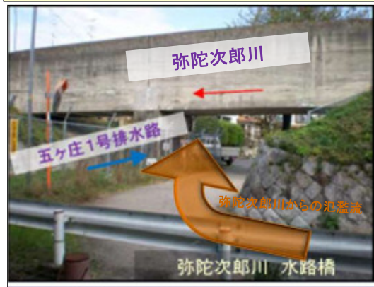
欠壊した弥陀次郎川の左岸からの氾濫流が弥陀次郎川の水路橋下部(五ヶ庄1号排水路)を流下し木幡池(南池)に流入
